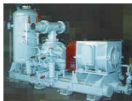
Рис. 15. Тепловой насос НТ – 1000 (раздельная компоновка)
