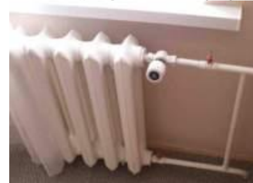
Автоматический балансировочный клапан (гидравлическое регулирование)
