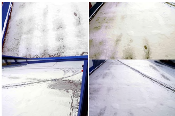
Рис. 3.24. Наружная часть перекрытия над подземной парковкой
