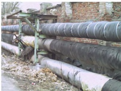
Рис. 4.35. Определение температуры поверхности трубы под теплоизоляцией
