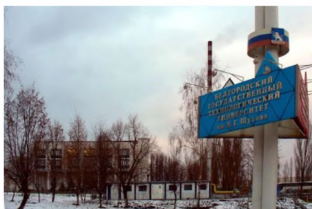
Рис. 4.2. Автономная котельная БГТУ им. В.Г. Шухова
