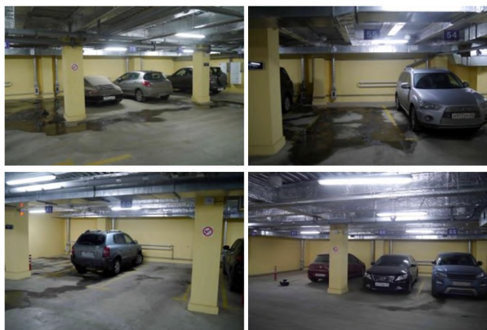
Рис. 3.25. Внутренняя часть подземного паркинга
