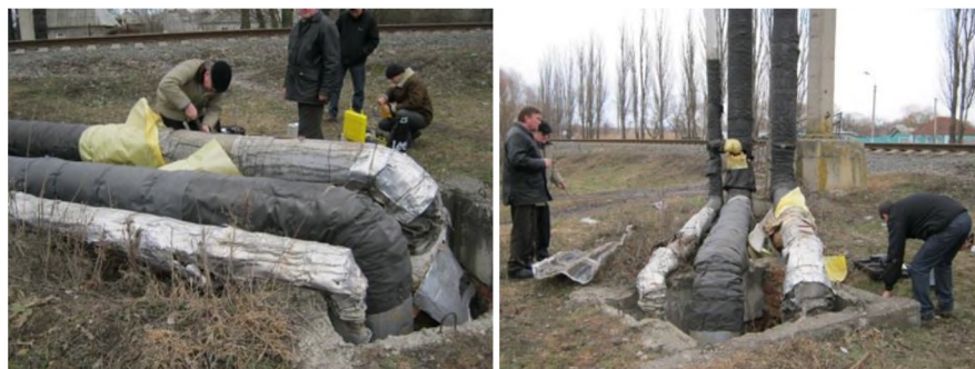
Рис. 4.33. Измерения на открытом участке теплотрассы
