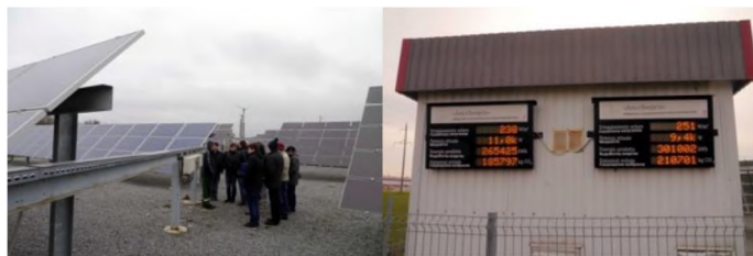
Рис. 4.6. Солнечная электростанция ООО «АльтЭнерго»
