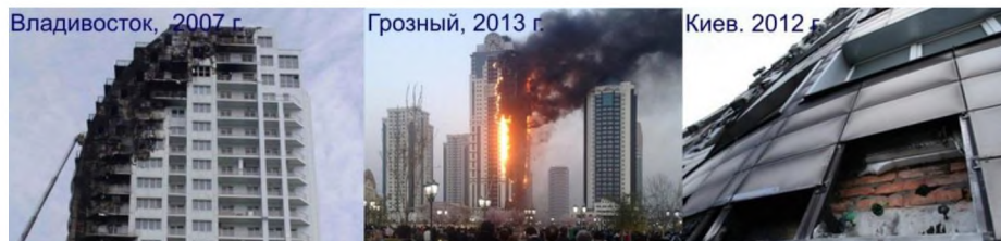
Рис. 1.14. Пожары в зданиях с навесным вентилируемым фасадом
