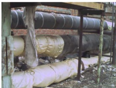
Рис. 4.35. Определение температуры поверхности трубы под теплоизоляцией
